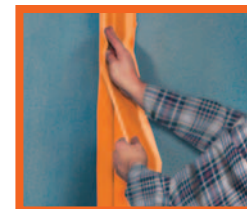
Eck- u. Kantenausbildungen mit FERMACELL Flüssigfolie versehen, mit FERMACELL Dichtband abkleben und ...
