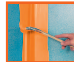
... abschließend nochmals sorgfältig mit FERMACELL Flüssigfolie an den Nähten überstreichen.
