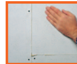
dann die FERMACELL Gipsfaser-Platten präzise auf Stoß kleben ...
