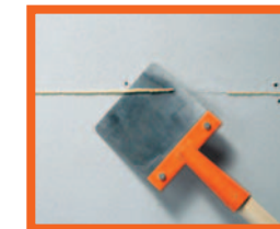
... und den ausgehärteten Kleber mit einem Spachtel abstoßen.
