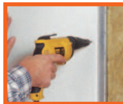
Platten beplankt und mit den FERMACELL Schnellbauschrauben befestigt.
