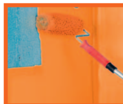
Im Wasser beanspruchten Bereich werden die Flächen dann mit FERMACELL Flüssigfolie überstrichen.
