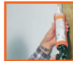
Den FERMACELL Fugenkleber auf der Kante der Gipsfaser-Platte auftragen,
