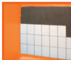
Nach dem Antrocknen kann direkt mit dem Endfinish (z.Bsp. Fliesenarbeiten etc.) begonnen werden.
