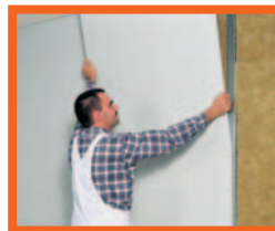
Das rückseitig verkleidete, mit Mineraldämmwolle ausgefachte Ständerwerk wird mit FERMACELL Gipsfaser-
